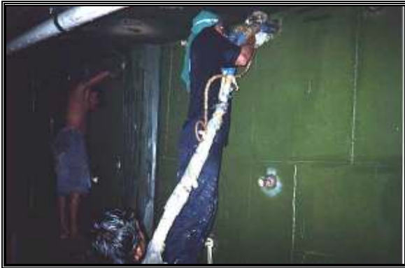
Aislamiento de Tinas de Atún en Navíos de Pesca. Puerto de Vacamonte, Panamá
