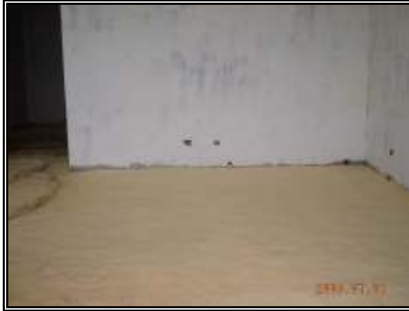
PUR Aplicada sobre losa de Concreto (Pacific Point Torre 600)
