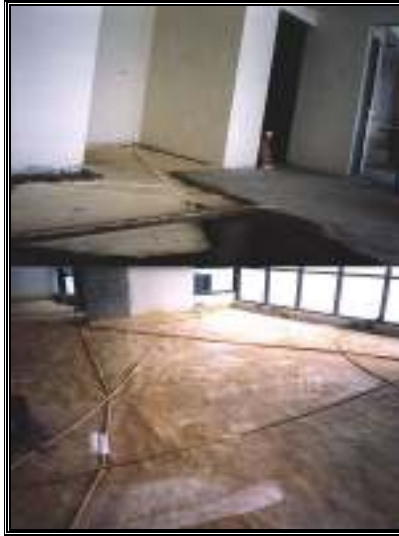
Aislamiento de Losa Torre Miramar, Panamá
