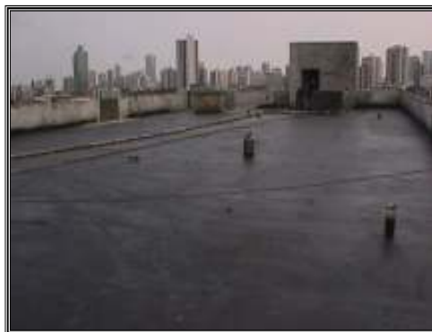
Impermeabilización de Losa Gate Tower, Panamá
