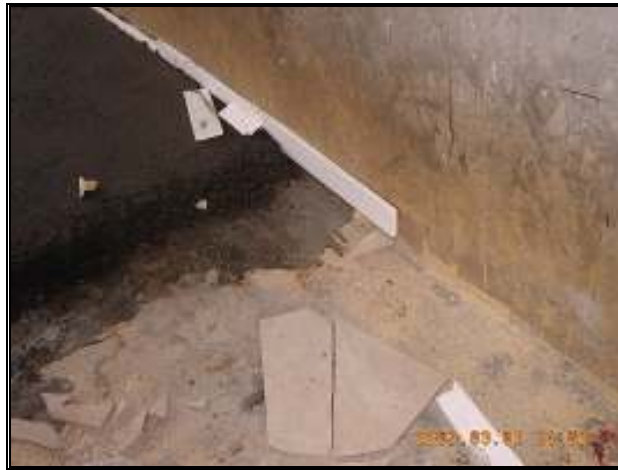
Mortero y Junta Perimetral sobre PUR
